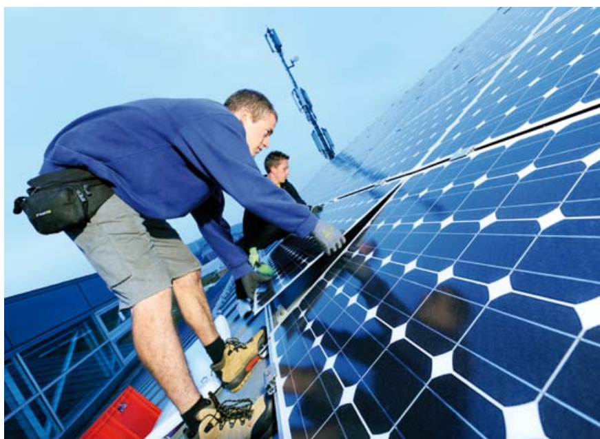
Montage sur le toit de la Foire de Zurich. © Photo: Frank Brüderli
