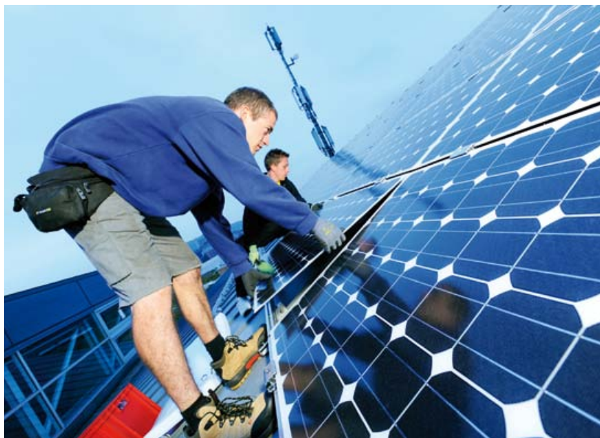
Bauarbeiten auf der Messe Zürich. ©Photo: Frank Brüderli
