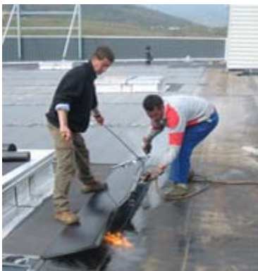
Ensuite, on soulève le module et on le chauffe, afin que les deux couches de bitume s'amalgament en fondant.
