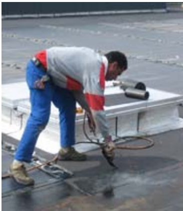
En premier, on chauffe la bande de bitume posée comme couche inférieure.
