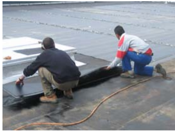
Le module, qui sur son côté inférieur est également pourvu d'une bande de bitume, est déposé sur la feuille de bitume déjà chauffée.
