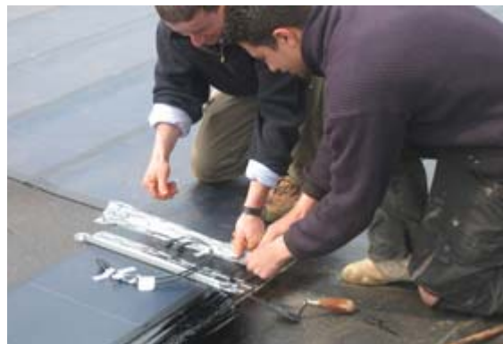
Vue du montage d'éléments destinés à protéger les connexions électriques.
