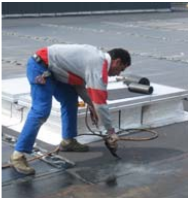
Als erster Schritt wird die untere Bitumenbahn angeschmolzen.
