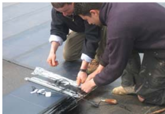
Hier werden Elemente für den Schutz der elektrischen Verbindungen montiert.
