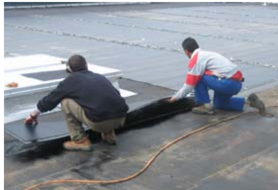
Das Modul, das auf der Unterseite auch mit einer Bitumenbahn versehen ist, wird auf die bereits fest verlegte und angewärmte Bitumenbahn gelegt.
