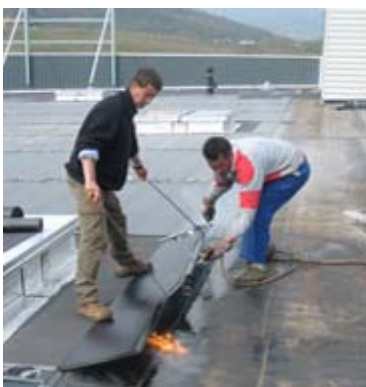
Nun wird das auf einer Bitumenbahn befestigte Modul angehoben und erhitzt, damit sich die beiden Schichten Bitumen durch Schmelzen verbinden
