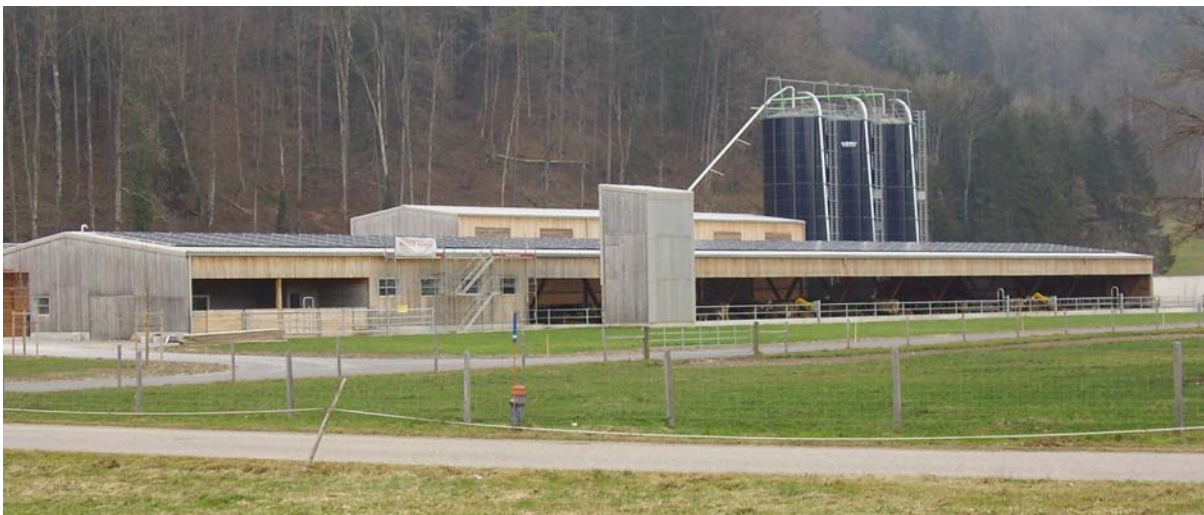
Installations à 100 kW Ifang/Zell (Tösstal)
