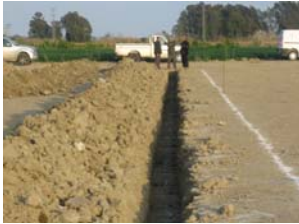
Début des travaux El Trujillo
