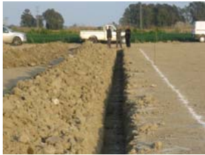
Baubeginn El Trujillo Spanien
