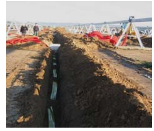
Tranchée pour câbles
