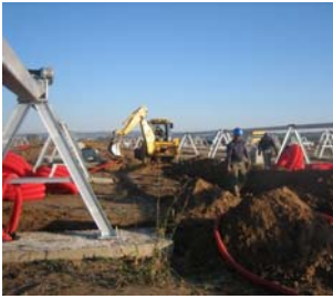
Pose de câbles
