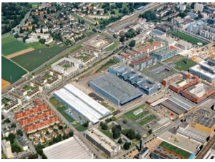
Hall de Tramont, Zürich
