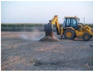
L'excavatrice au travail
