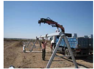
Pose de l'ossature porteuse
