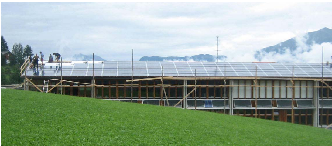
Anlage "Schule Flerden"
