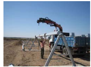
Setzen der Unterkonstruktion
