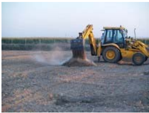
Der Bagger fährt auf
