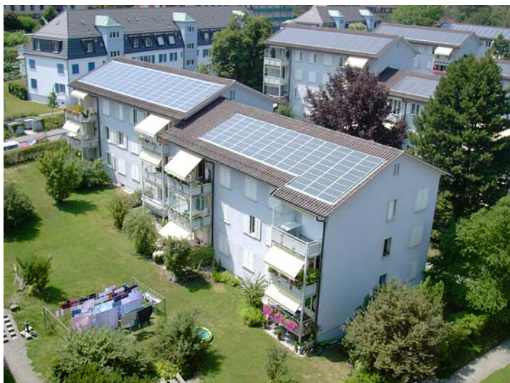
Installation Moos de l'ABZ
